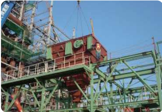
| 열병합 PROJECT 집진기 설치 |
