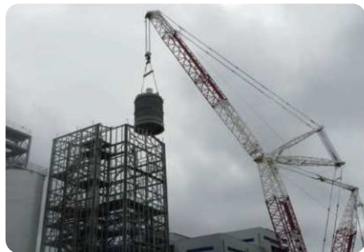
| CPC PROJECT 기기설치 |
